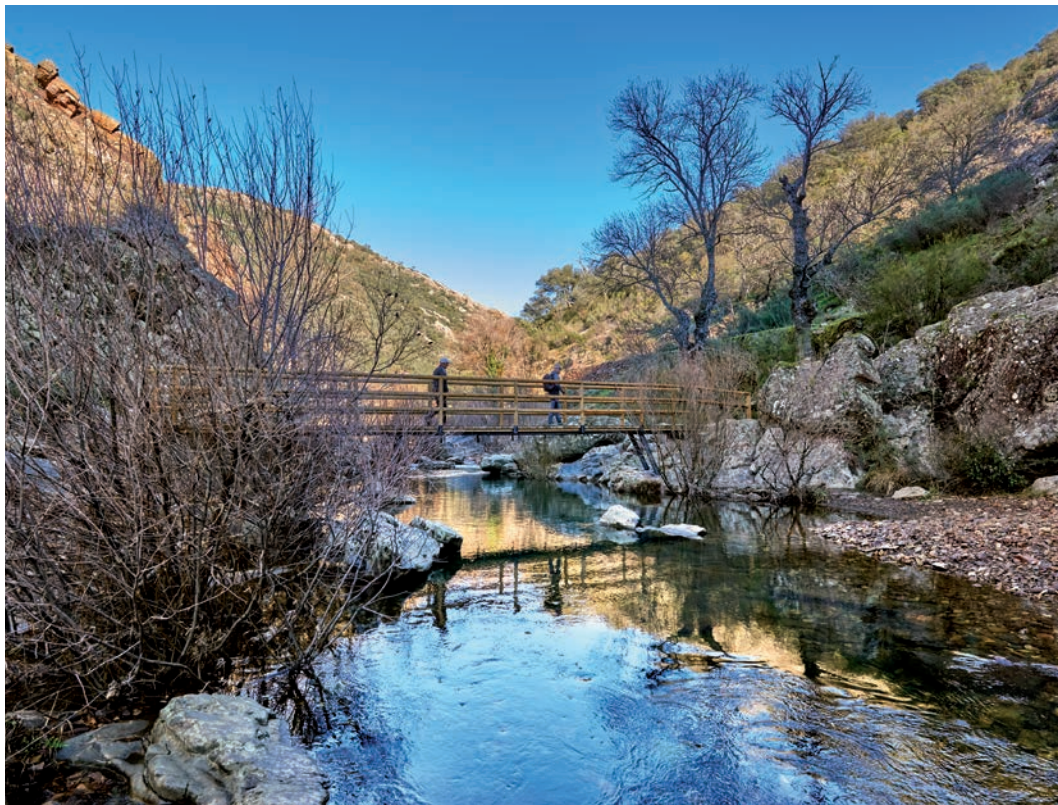
Puente sobre las aguas del Estena.
